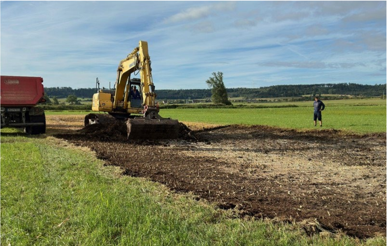
Erneuern einer „verschliffen“ Mulde bei Eckartsweiler durch das Projekt (Foto Dietmar Herold)
